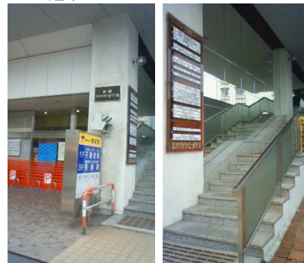
本社ビル入口は2Fにあります。
